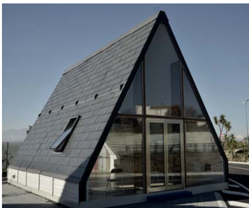
■ La casa «Madi» (Modulo abitativo dispiegabile) alla fine del montaggio
